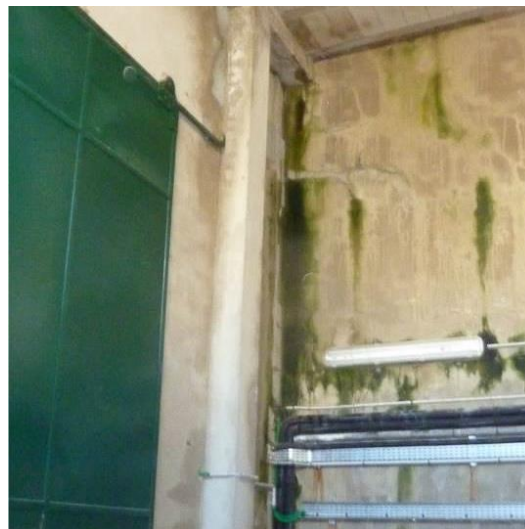
Figure 54 : Bât D - Infiltration, présence d'humidité
