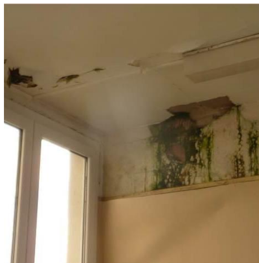
Figure 51 : Bât C-E - Infiltration SAS accès bât A
