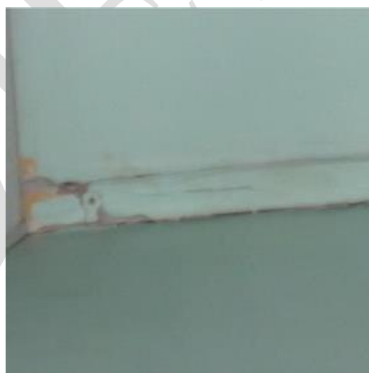
Figure 34 : Bât B - Suspicion de tassement différentiel
