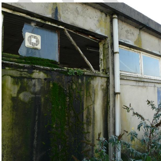
Figure 14 : Zédé - Châssis détériorés et vitres cassées
