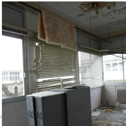
Figure 17 : Zédé - Plafond détérioré
