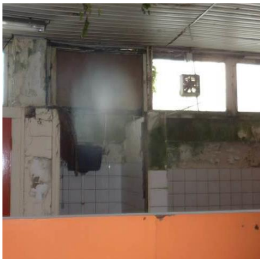
Figure 16 : Zédé - Humidité et végétation
