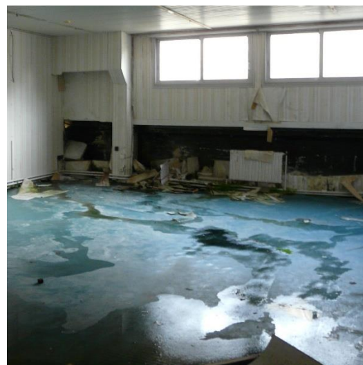
Figure 15 : Zédé - Infiltration d'eau
